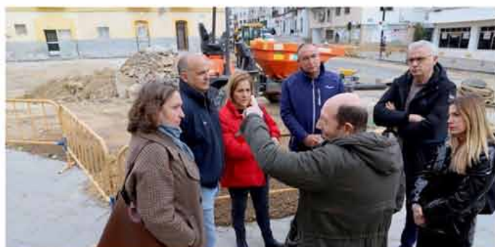
Las obras en la Plaza del Carbón.
