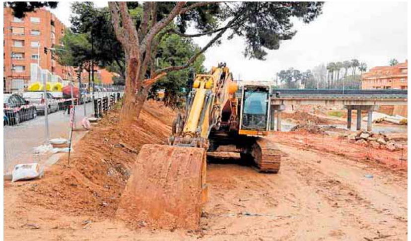
Obras en el barranco del Poyo a su paso por Paiporta paralizadas temporalmente por las lluvias. JESÚS SIGNES
