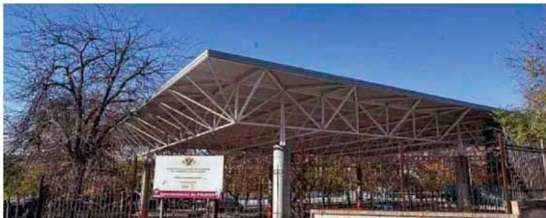
La cubierta de la pista de patinaje de la Escuela de Gimnasia dispondrá de placas fotovoltaicas. / YOLANDA LANCHAS
