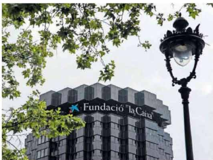
Fachada de una de las torres de la sede de La Caixa, en Barcelona. ALBERTO PAREDES (GETTY)
