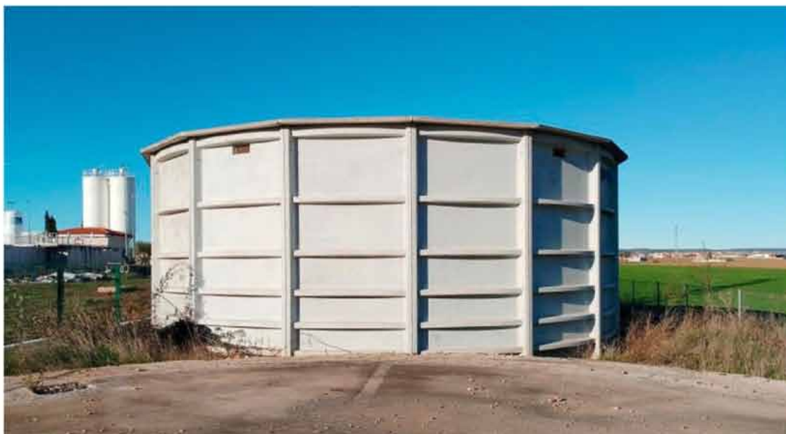
Castilla- Mancha concreta conexión abastecimiento Muela garantizar agua
